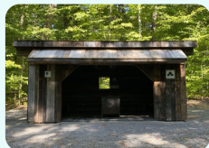
Abris post-chantier Mirabel
