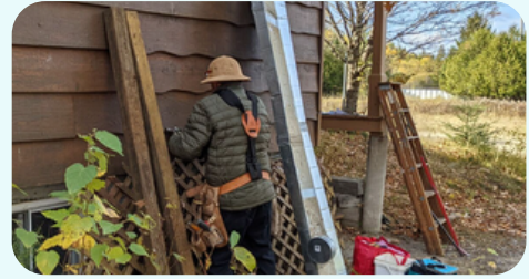
Extraction pré-chantier MRC des Laurentides
