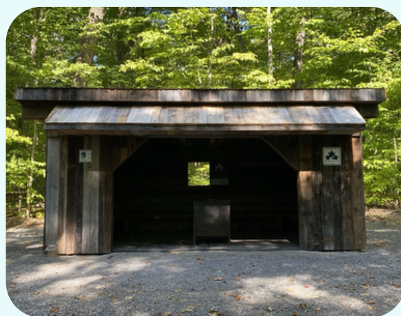
Abris post-chantier Mirabel
